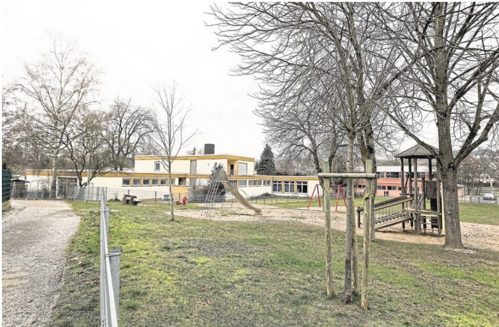
Der Stadtrat hat, nachdem der Ortsbeirat in einer Sondersitzung einstimmig seine Empfehlung ausgesprochen hatte, den Weg freigemacht für den Neubau einer Kita in Oberbieber. Beigeordneter Ralf Seemann hofft, dass im Herbst mit den Arbeiten begonnen werden kann.
