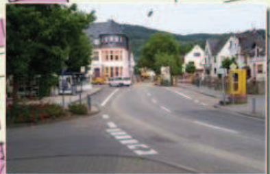
Verlegung der Bushaltespur
